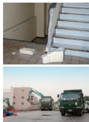
被災、損壊した生田3号館の2F中階段。建物は昨秋、取り壊された
