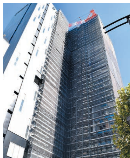
建設中の神田10号館(専修大学140年記念館) 2019年10月撮影
